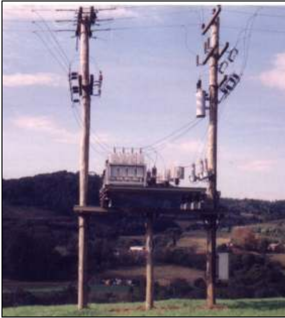
Figura15 - Implementação do sistema de compensação série
