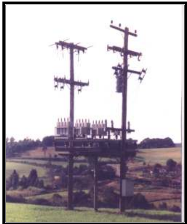
Fig.17 - Implementação do sistema de compensação série
